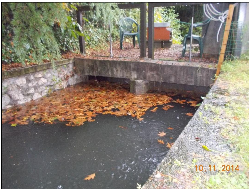
Foto 2: dettaglio chiusura paratie Acquanegra
